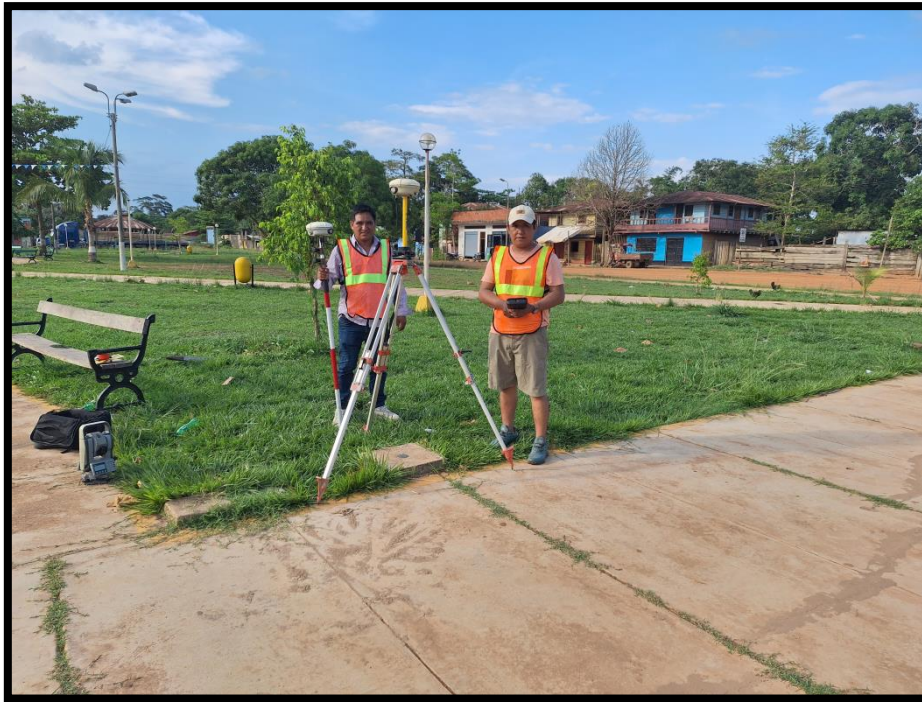
se coloca equipo geodésica en el BM-02
