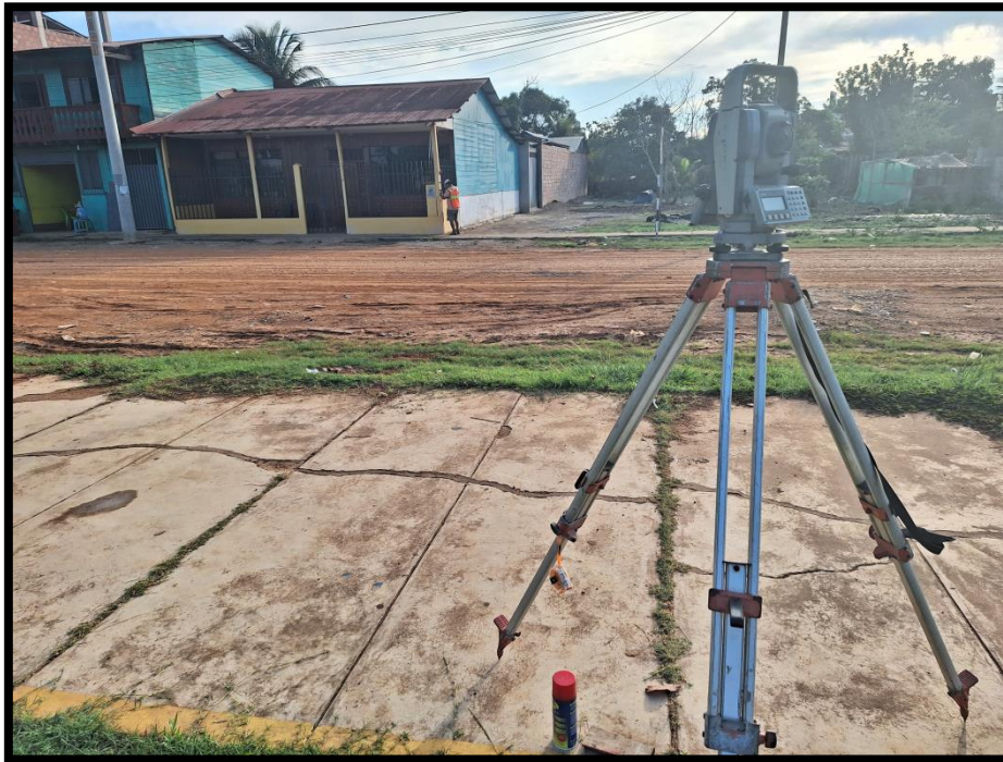
Se toma medidas del terreno con estación total
