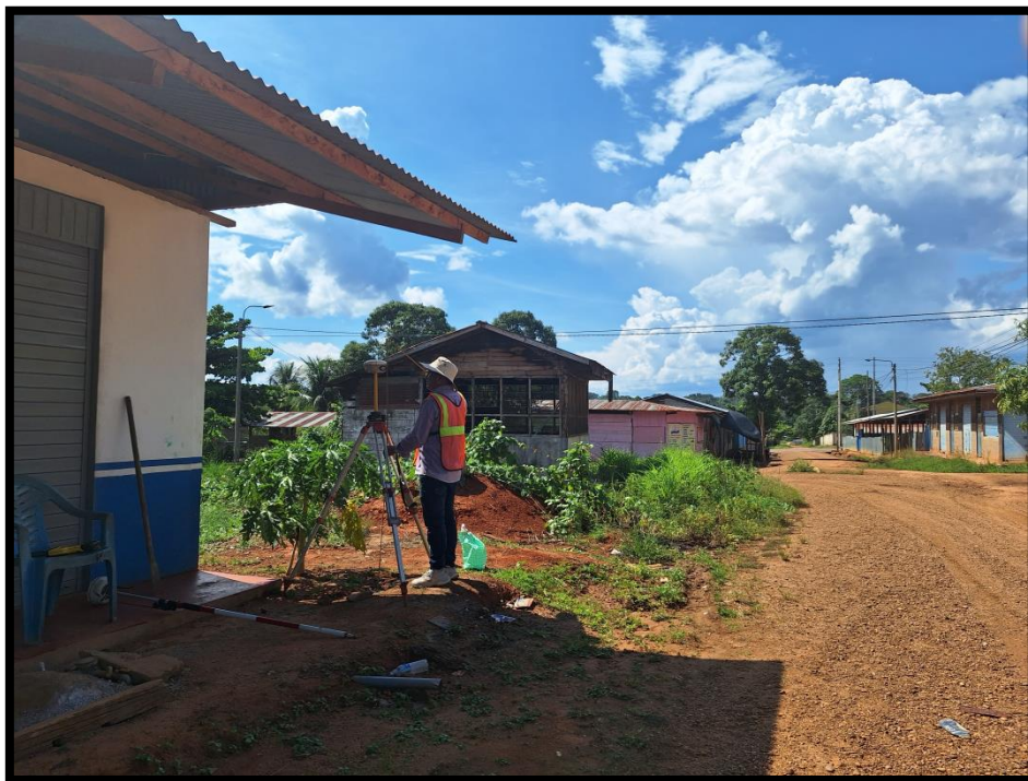
Estacionamiento de equipo para recopilar puntos
