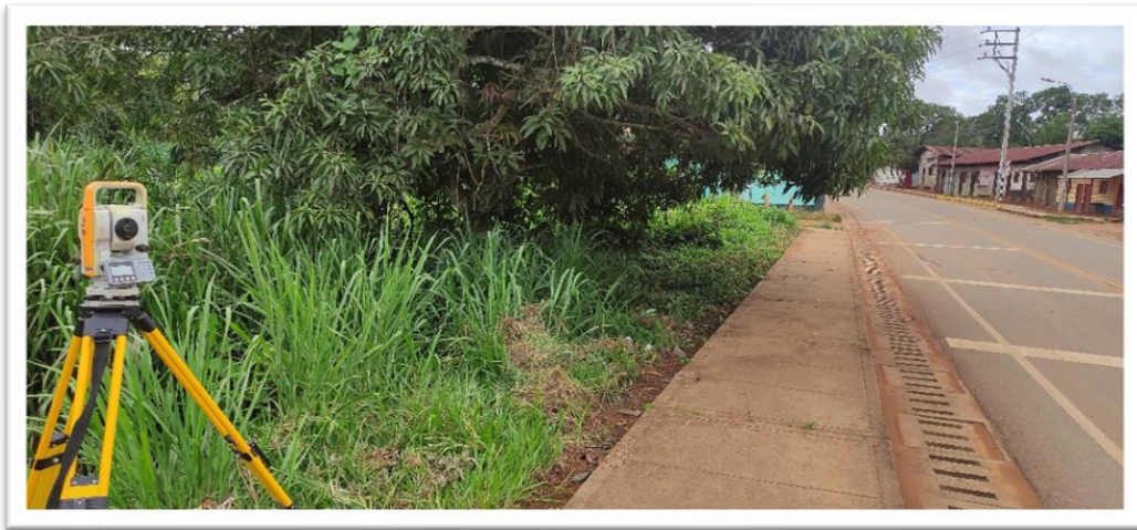
toma de puntos del terreno – vereda y canal
