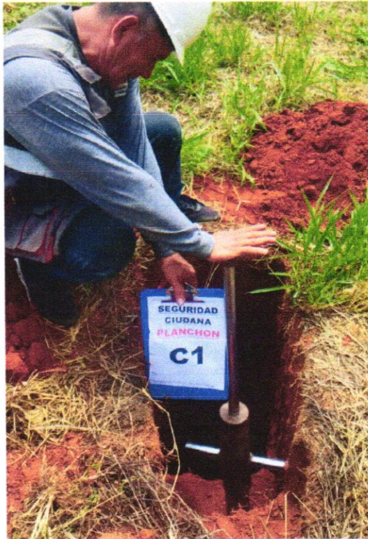
REGISTRÓ PANORAMICO DE EXCAVACIONES CALICATA C-1
